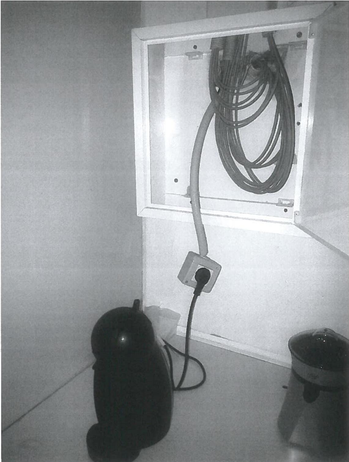
Un cuadro de maniobra eléctrico de segunda planta, disimulado en un armario, no está señalizado de forma reglamentaria. El extintor de polvo seco instalado en sus inmediaciones está ubicado al final de un pasillo y demasiado próximo al cuadro de maniobra, incluso pudiendo quedar totalmente ocultado si se abre la puerta derecha. En el interior del armario del cuadro eléctrico se almacena material de construcción que podría comprometer el acceso y agravar un incendio.
